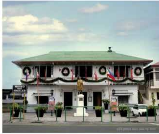
Old Municipio Building
